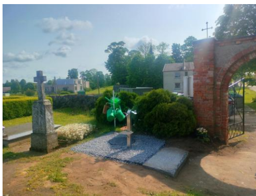
Sutvarkyta vandens sistema, įrengtas čiaupas Kantaučių kapinėse
