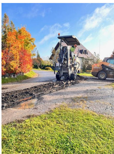
Asfalto duobių remontas
