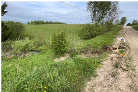
Vandens pralaida prieš remontą
