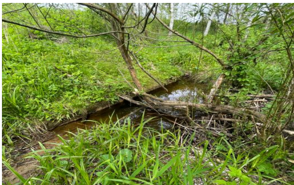
Vandens pralaida prieš remontą
