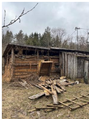
Pastato griovimo darbai Burbaičių k.
