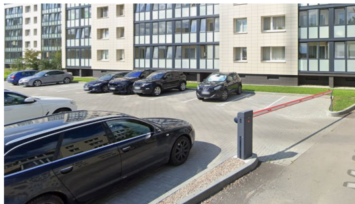
Žaliosios erdvės vietoje įrengta nelaidžių dangų stovėjimo aikštelė V. Mažernio g. 7, Plungė.
