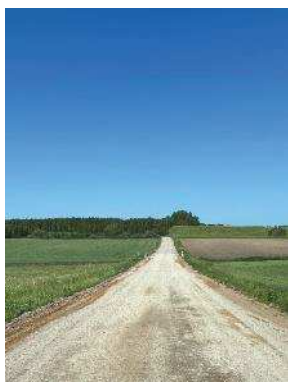
Šateikių Rūdaičių k. Ramioji g. dangos atnaujinimas pilant skaldos
