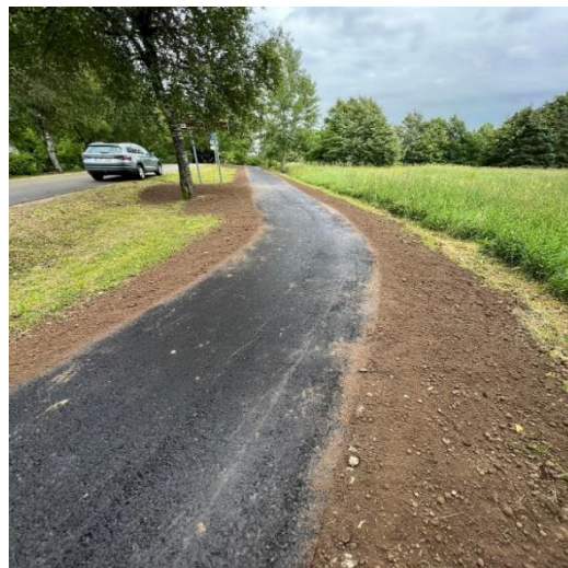
10 pav. Pėsčiųjų-dviračių tako remontas Ežero grioviai, suformuoti nuolydžiai, atvežta skaldos
