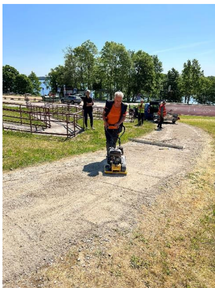
1, 2 pav. „Šeirės“ pėsčiųjų-dviračių tako dangos atnaujinimas
