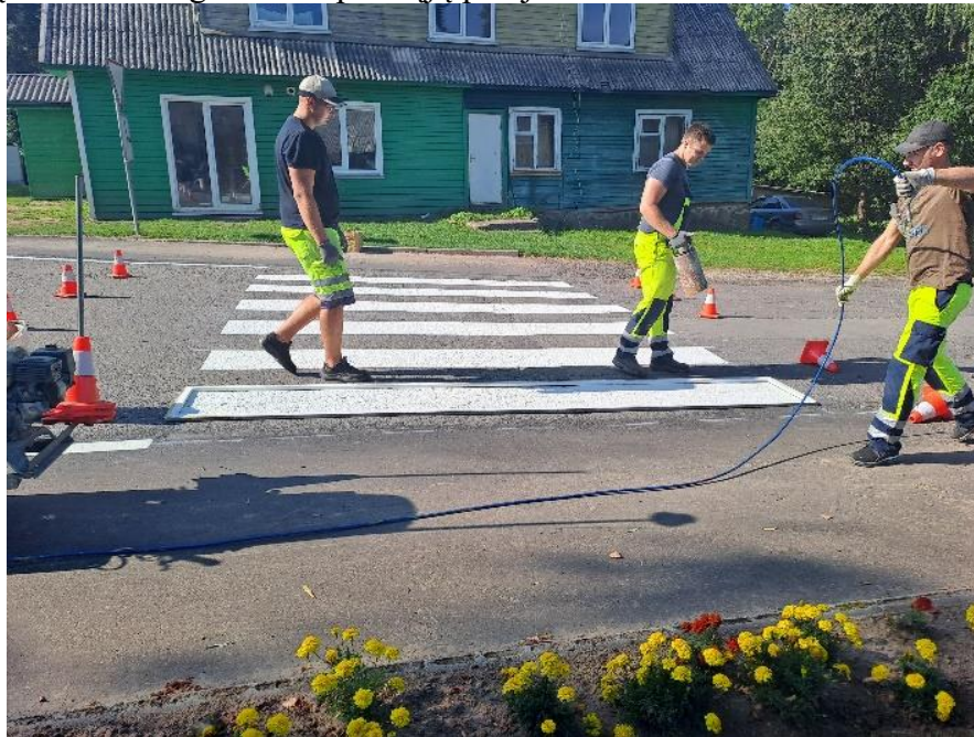
1 pav. Pėsčiųjų perėjos įrengimas
