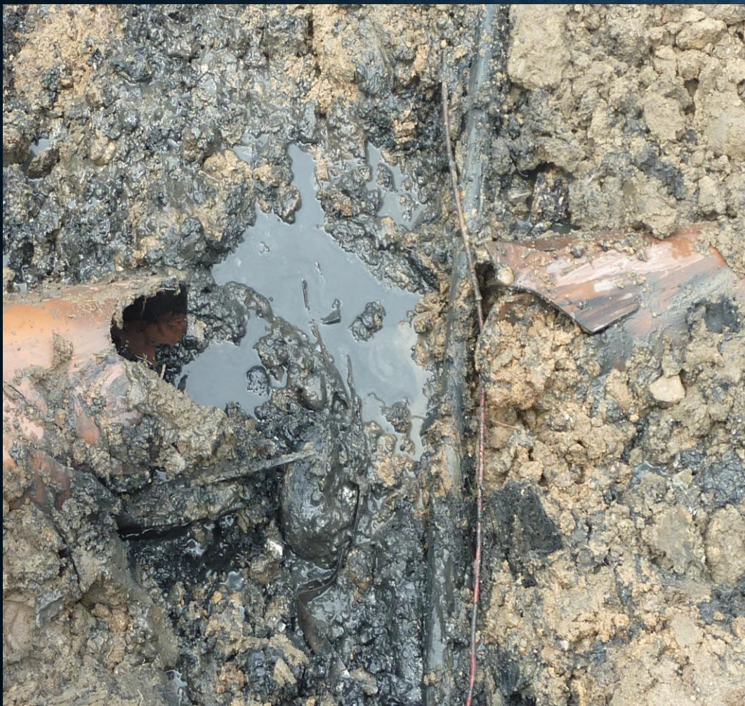
Optinio kabelio tiesimo metu sugadintų nuotekų tinklų remontas Aleksandravo kaime
