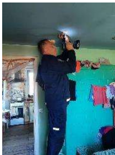
Pav. 9. Autonominiai dūmų detektoriai
