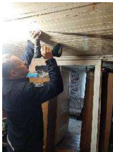
Pav. 9. Autonominiai dūmų detektoriai
