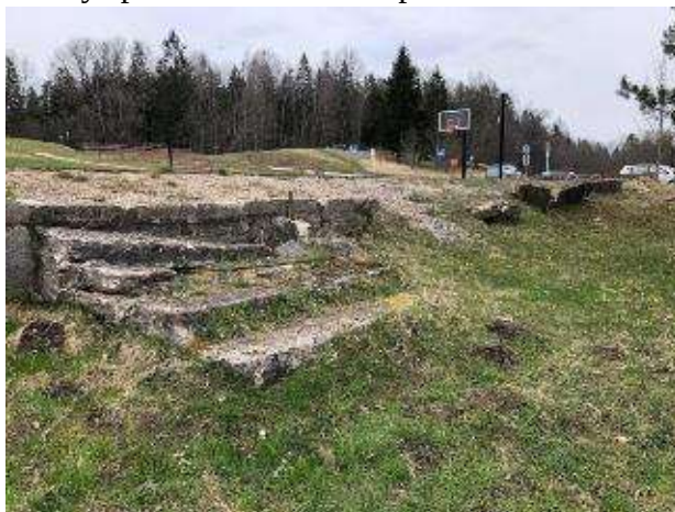
1, 2 pav. Gelžbetoninė sienelė PRIEŠ rekonstrukciją
