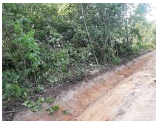
Pav. 2. Alksnėnų k. Sodų g. kelio griovio pagilinimas vandens nubėgimui prieš ir po
