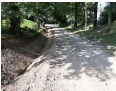
Pav. 1. Kadaičių k. Blendžiavos g. kelio griovio pagilinimas vandens nubėgimui
