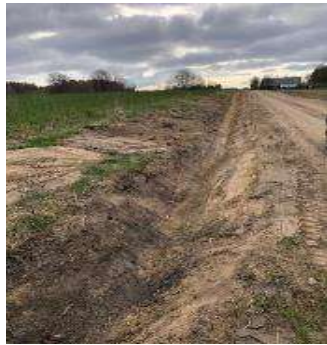
5, 6 pav. Drenažinių griovių kasimas ir nuolydžio formavimas Pupkulių g.
