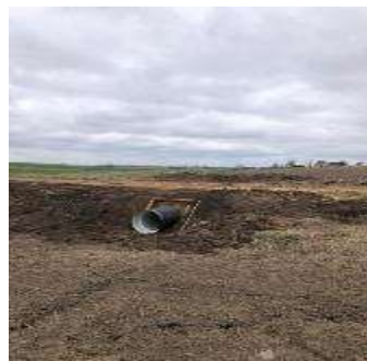
7, 8 pav. Pralaidos įrengimas, drenažinio griovio nuvedimas Pupkulių g.
