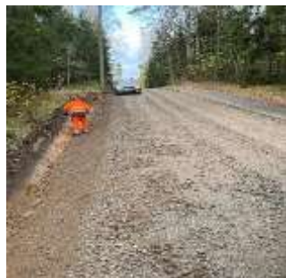
11 pav. Šilinės g. remontas. Iškasti pakelės
