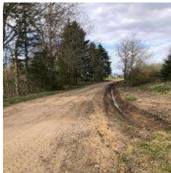
9, 10 pav. Kelio dangos nuolydžių formavimas, drenažinių griovių kasimas Gintališkės g.
