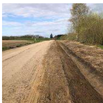
9, 10 pav. Kelio dangos nuolydžių formavimas, drenažinių griovių kasimas Gintališkės g.
