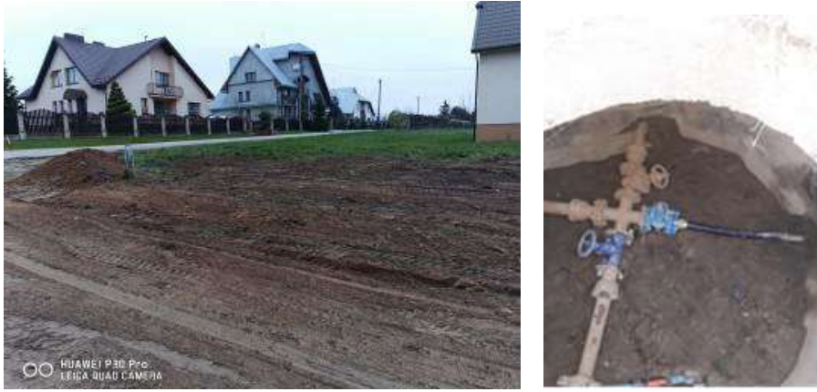
Atlikti irklavimo bazės komunikacijų įrengimo darbai.
