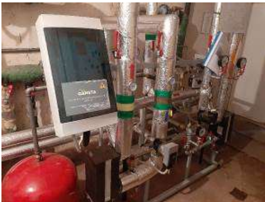
Atnaujinti šilumos punktai l/d „Raudonkepuraitė“, l/d „Rūtelė“
