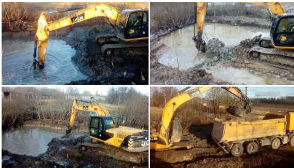
11 paveikslas. Užteršto grunto kasimas ir pakrovimas į sunkvežimius.
