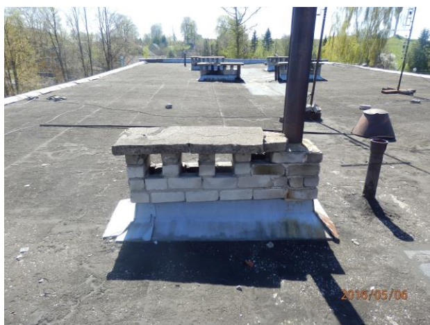
Suremontuotas Alsėdžių gimnazijos bendrabučio stogas
