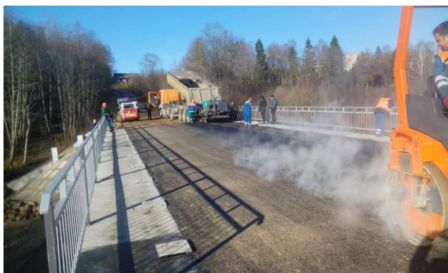
Tilto per Babrungo upę remonto darbai
