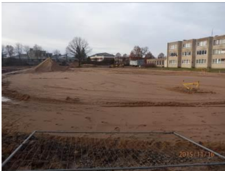
2 pav. Atlikti „Saulės“ gimnazijos stadiono pagrindų įrengimo darbai
