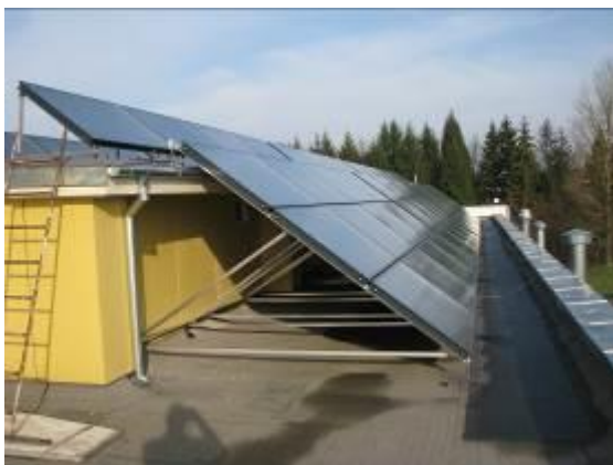
3,4 pav. Plungės rajono savivaldybės ligoninėje įrengta saulės kolektorių sistema
