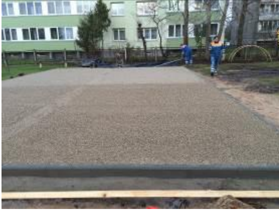
6, 7 pav. Paruošti pagrindai mini futbolo aikštelių įrengimui
