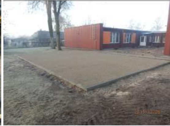
6, 7 pav. Paruošti pagrindai mini futbolo aikštelių įrengimui
