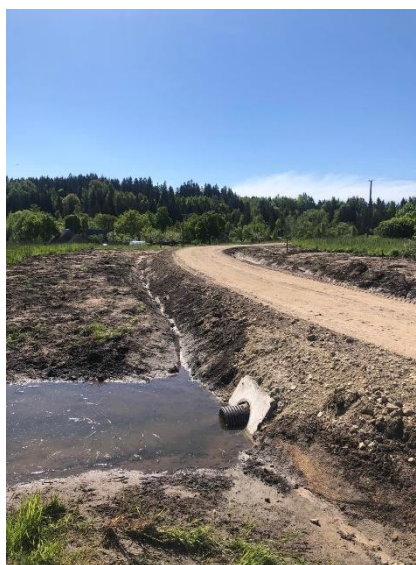
9, 10, 11 pav. Kelio dangos nuolydžių formavimas, drenažinių griovių kasimas, pralaidų įrengimas Šeirės g.
