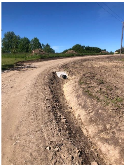
9, 10, 11 pav. Kelio dangos nuolydžių formavimas, drenažinių griovių kasimas, pralaidų įrengimas Šeirės g.
