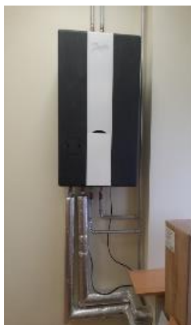
Atnaujintas šilumos punktas, naujai pajungti radiatoriai (Šachmatų klubas).
