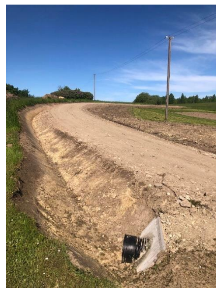
9, 10, 11 pav. Kelio dangos nuolydžių formavimas, drenažinių griovių kasimas, pralaidų įrengimas Šeirės g.
